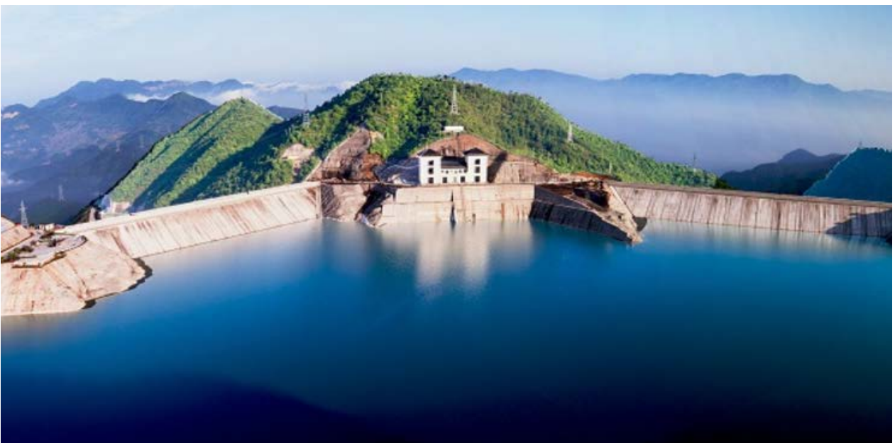
浙江仙居抽水蓄能电站工程
