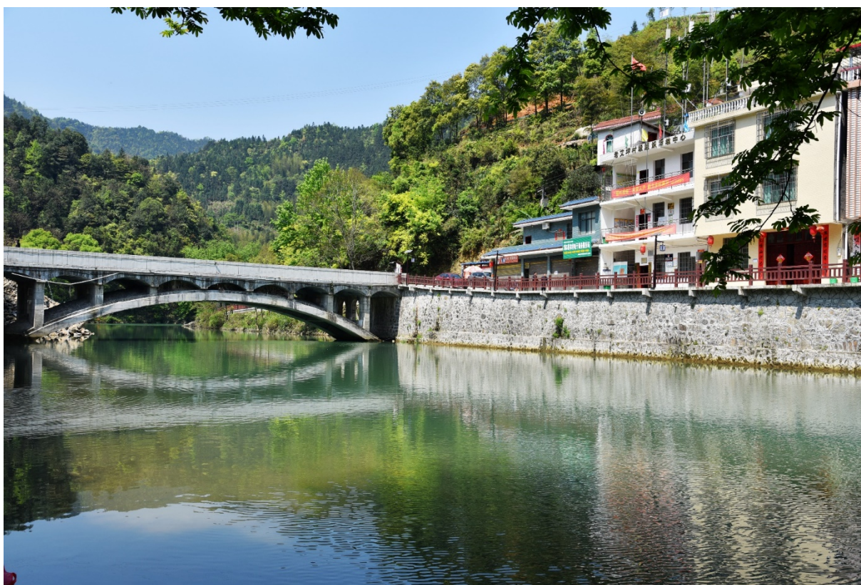
洞口县长塘瑶族乡老艾坪村现状
