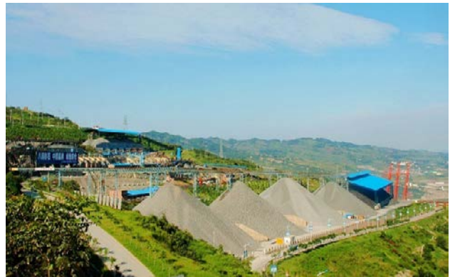
金沙江向家坝水电站砂石加工系统
