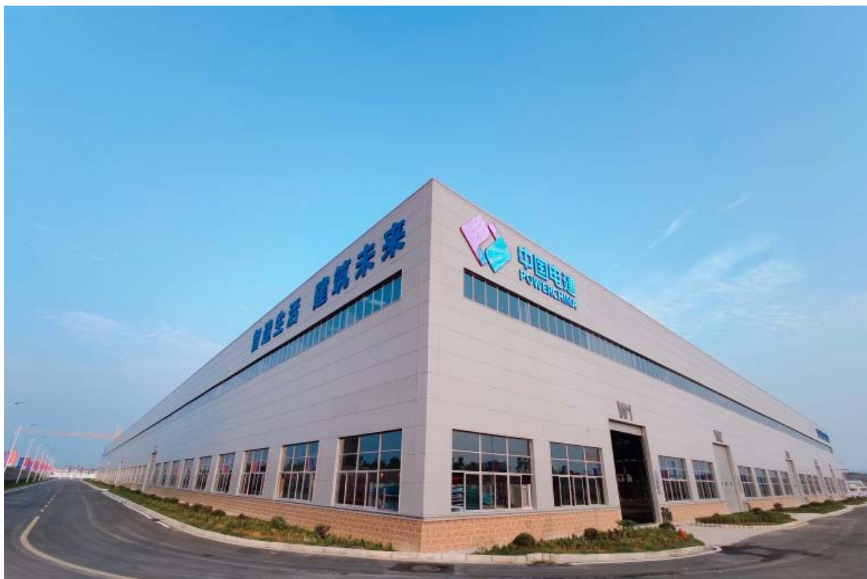
安徽池州装配式建筑预制构件生产基地
