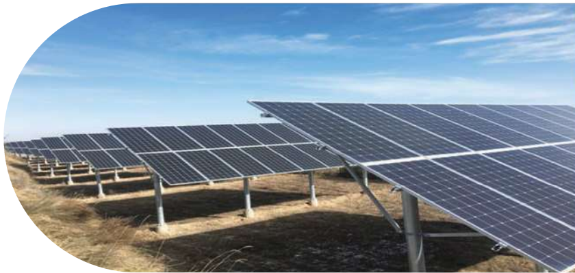
威勝2019年「十三五」光伏扶貧村級電站建設項目
