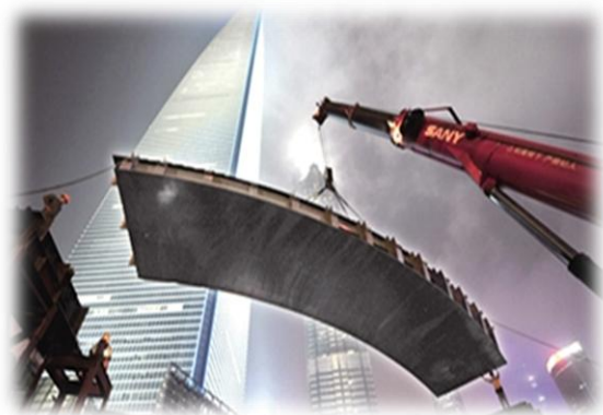
三一起重机正在上海陆家嘴施工
