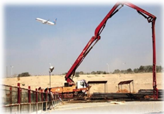
三一泵车正在武汉地铁6号线施工
