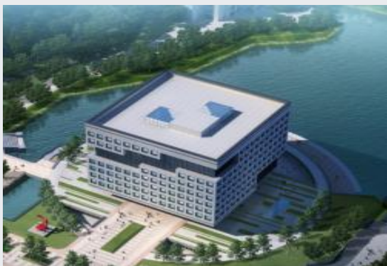
<南华大学雨母校区图书馆> 工程改造+智慧能源平台部署运营
