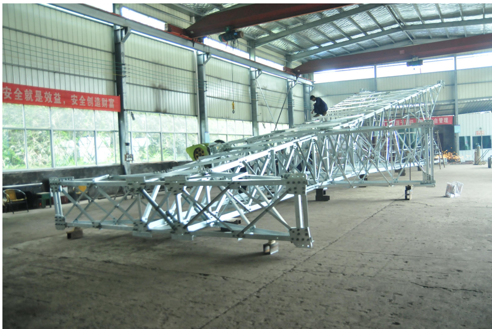
组装待检铁塔
