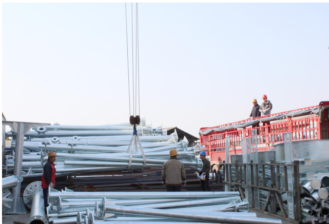
公司仓库外吊装电力器材送往项目现场
