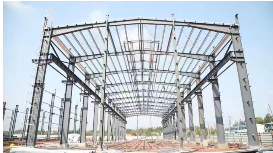
新建制造基地项目建设现场
