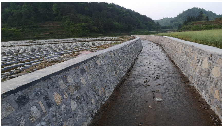
五里坪村溪坝修缮改造
