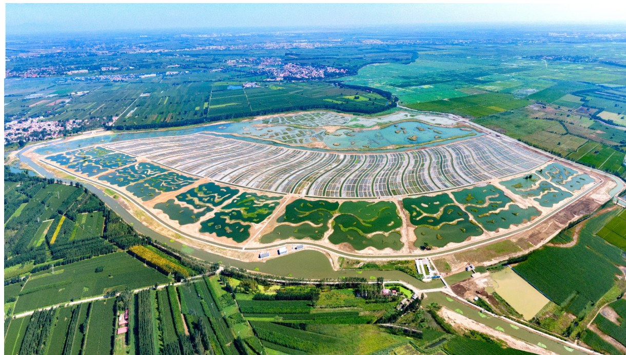
雄安新区府河河口湿地水质净化工程
