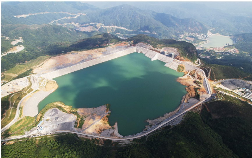
福建厦门抽水蓄能电站
