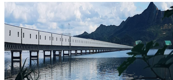
池州长九神山灰岩矿项目全封闭物流廊道
