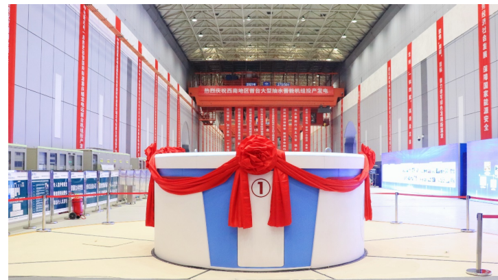
重庆蟠龙抽水蓄能电站1#机组
