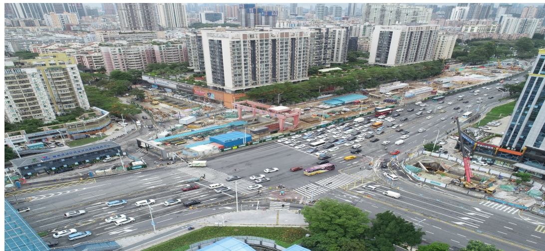
穗莞深城际铁路工程
