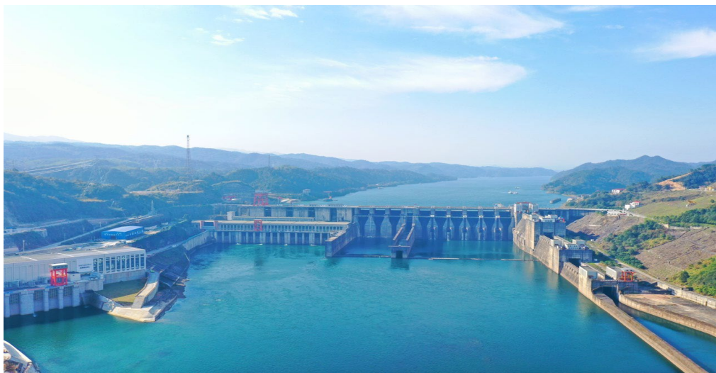
五强溪水电站
