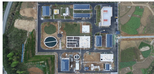
江西都昌县污水处理工程
