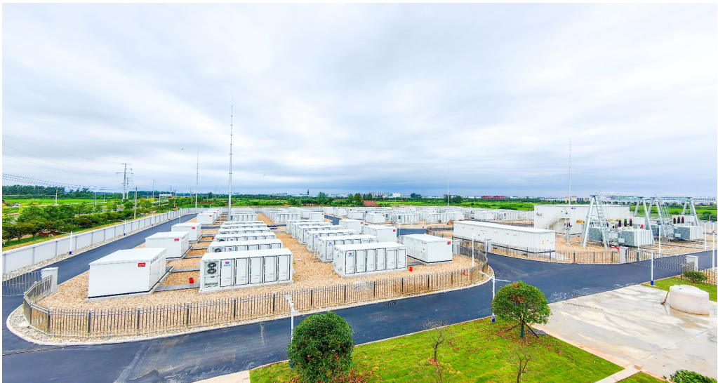
西洞庭100MW/200MWh储能电站项目
