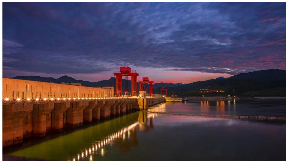
广西大藤峡水利枢纽工程
