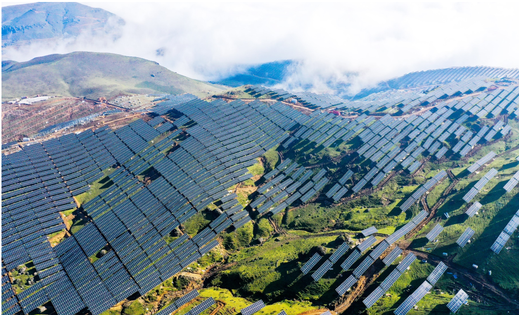
云南省巧家县羊窝头65MW光伏项目
