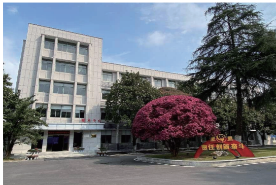
● 华菱线缆技术中心大楼
