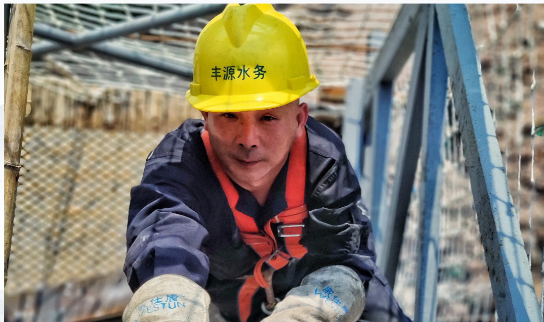
给水管线施工现场
