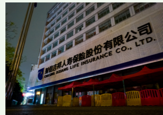
财信人寿长沙中支办公楼熄灯前后
