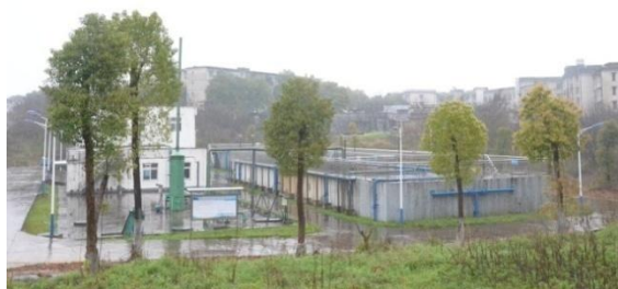
公司污水处理站
