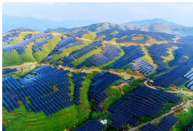
云南巧家海坝240MW光伏电站
