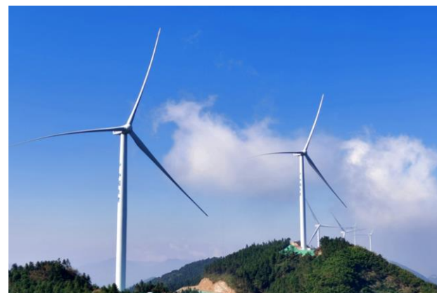
郴州江口风电场工程——中国电建优质工程奖
