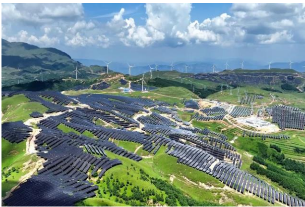
云南小羊窝50兆瓦光伏电站项目
