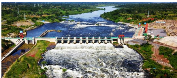
乌干达最大水电站——卡鲁玛水电站
