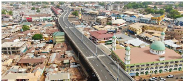
加纳塔马利立交桥
