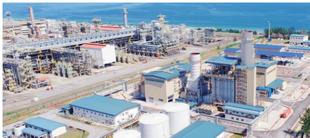
马来西亚凯德隆联合循环电站
