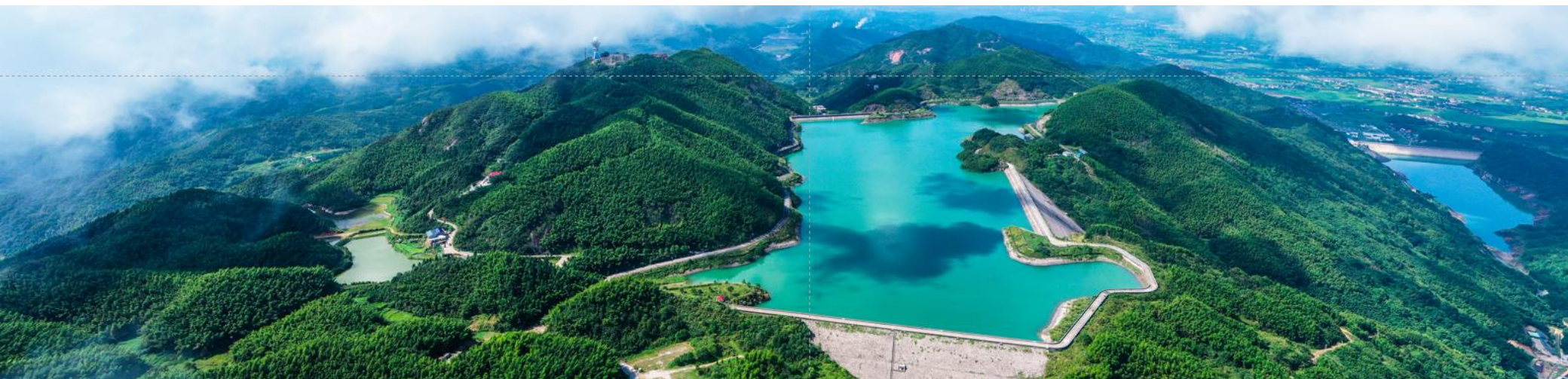
湖南省第一个抽蓄电站——黑麋峰抽水蓄能电站
