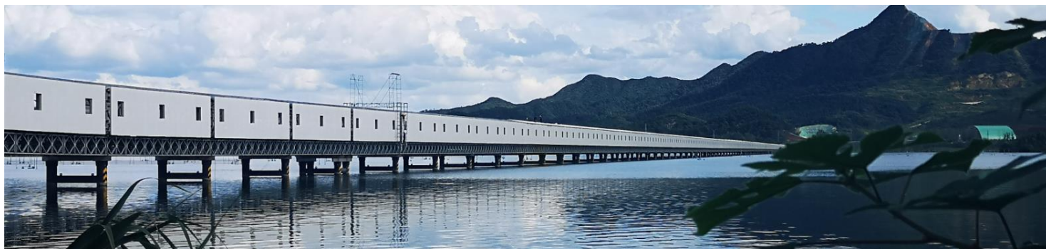
安徽池州长九神山灰岩矿项目全封闭物流廊道
