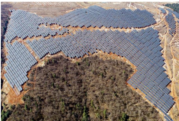
云南赤鹜光伏项目
