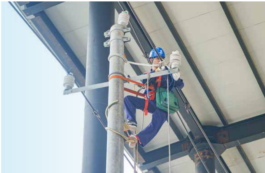
▲“电力励志工程”2019级定向培养学生技能比武——更换绝缘子
