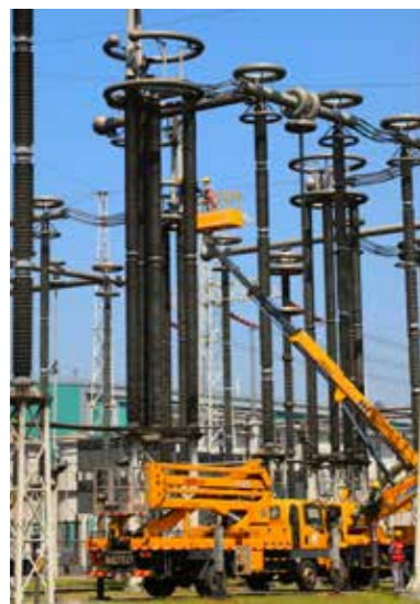
▲ ±800 千伏韶山换流站年度检修
