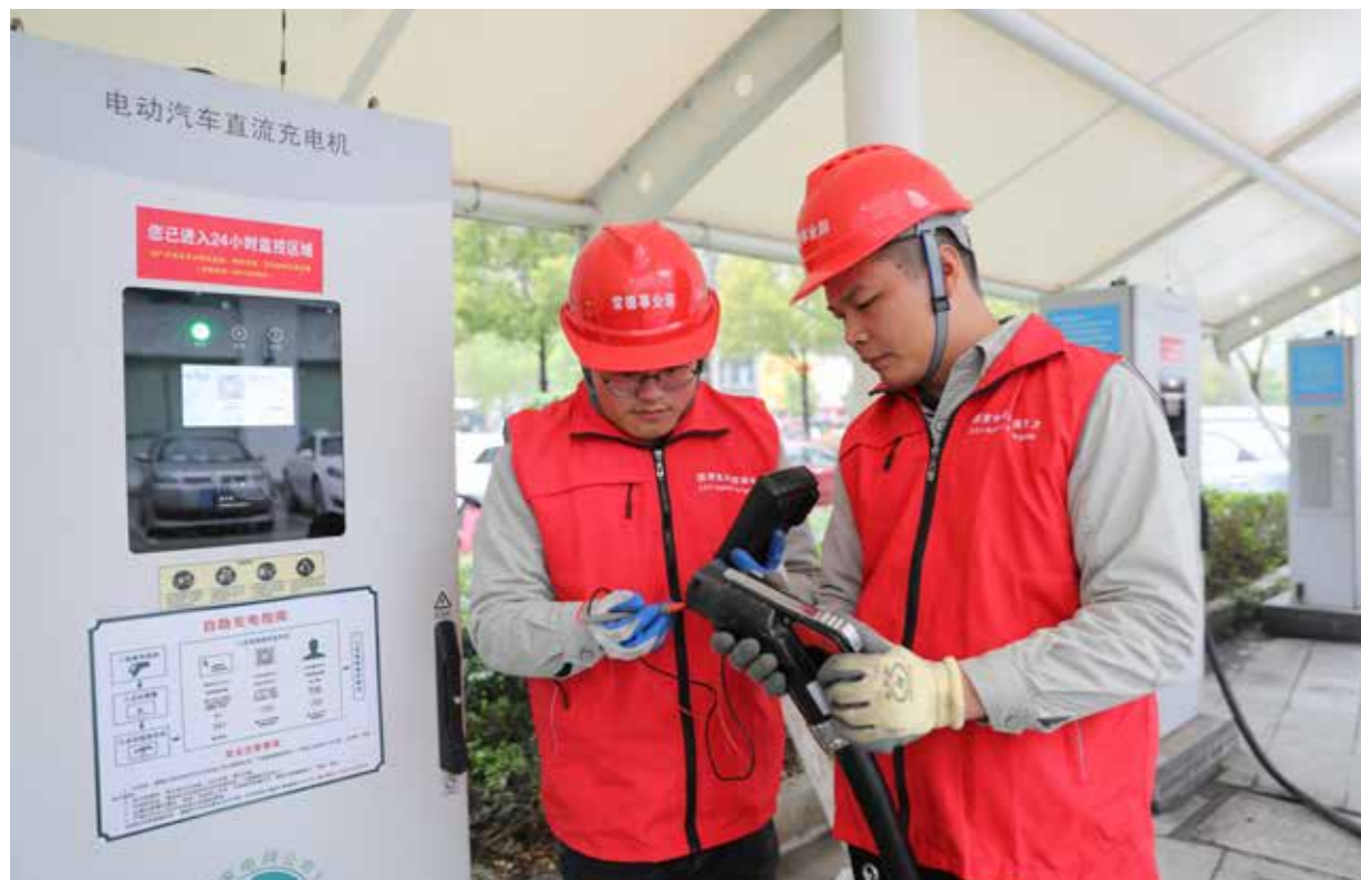
▲ 电动汽车公司运维人员在充电场站进行春检巡视
