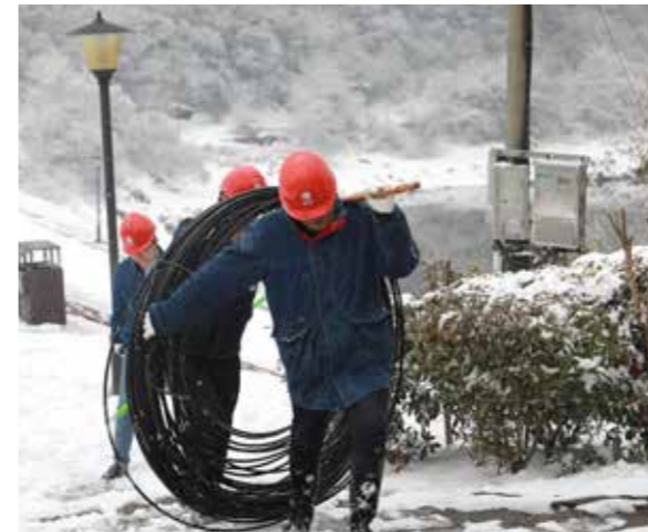
▲ 长沙供电公司抗冰保电
