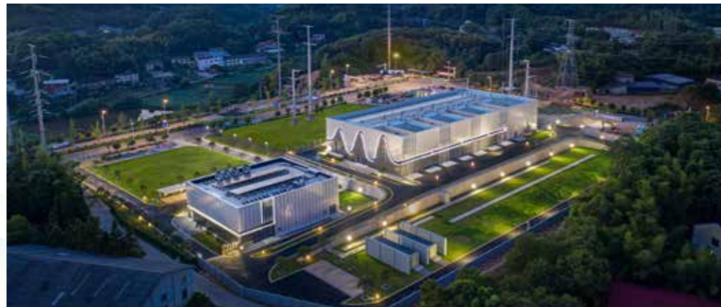
▲ 国内首座 220 千伏智慧能源站——株洲成家（白关）220 千伏智慧能源站投运
