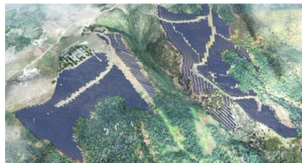
云南富民赤鹭100兆瓦光伏电站
