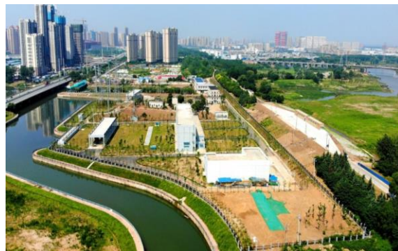
武汉后湖四期泵站项目（大禹奖）
