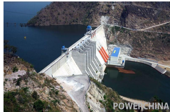
加纳的第二大水电站—加纳布维水电站
