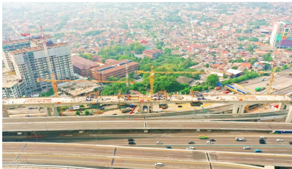
2021年9月30日，印尼雅万高铁25处连续梁全部合龙
