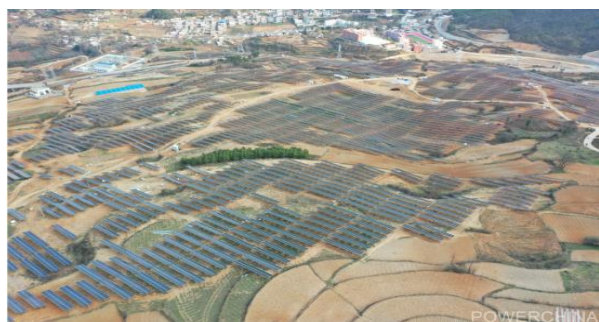
贵州威宁半坡农业光伏电站
