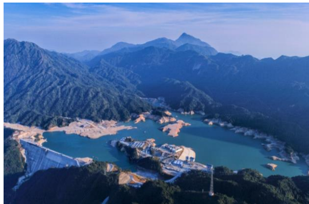
广东阳江抽水蓄能电站
