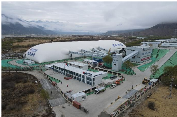
西藏尼洋河砂石项目
