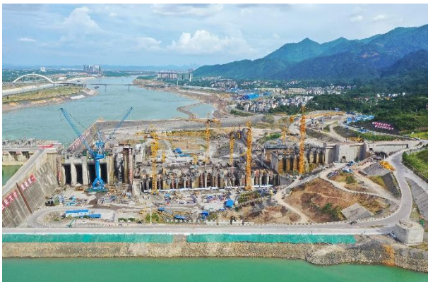
大藤峡右岸厂坝项目
