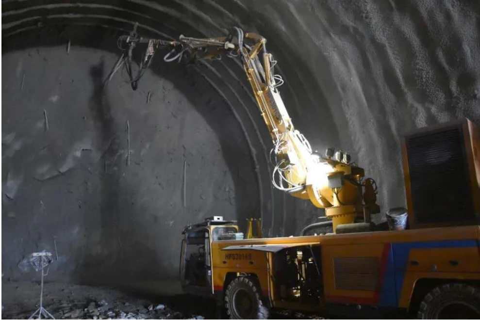
智能型锚杆台车在杨家坪隧道施工
