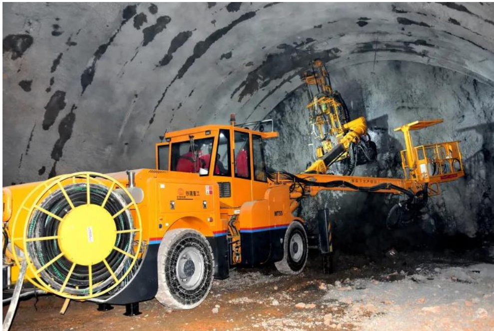
智能型锚杆台车在杨家坪隧道施工
