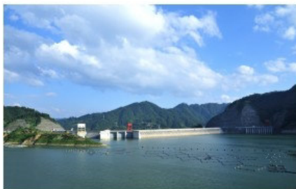
三板溪水电站
