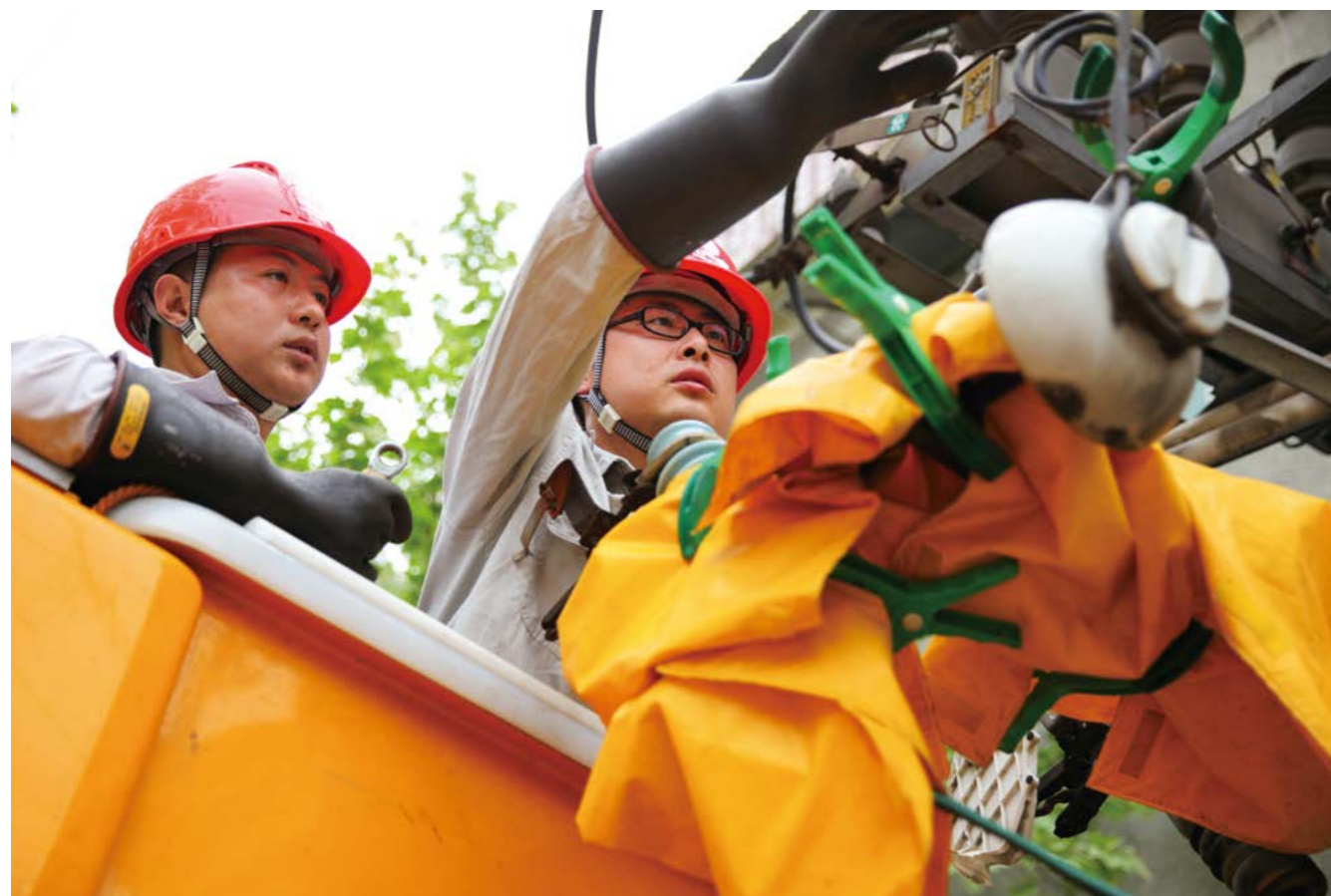
电力员工开展带电作业
