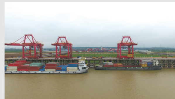
靠岸船舶使用电力清洁能源靠岸接驳
